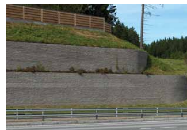
Autostradowe konstrukcje oporowe zaprojektowane na okres trwałości 120 lat.
