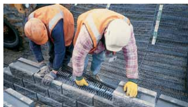
Wznoszenie konstrukcji jest proste, nie wymaga wyspecjalizowanej kadry pracowniczej i specjalistycznego sprzętu.
