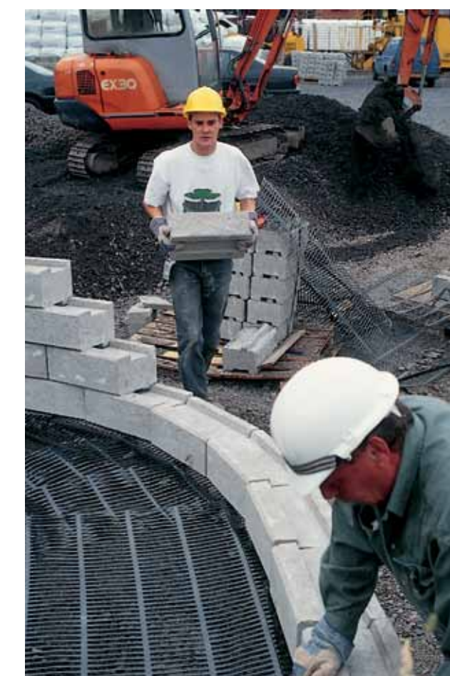
Bloczki TW1 są dostarczane na miejsce instalacji na paletach i układane ciasno w łuku wklęsłym lub wypukłym.
