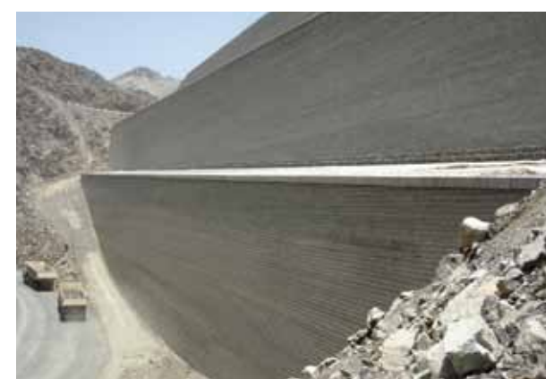
Nawet przy budowie konstrukcji o tak znacznych rozmiarach jak ta w Emiratach Arabskich, nie ma potrzeby używania specjalistycznego ciężkiego sprzętu ani wykonywania deskowania.
