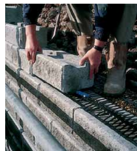
Bloczki TensarTech TW1 układane są na sucho, bez zaprawy murarskiej.
