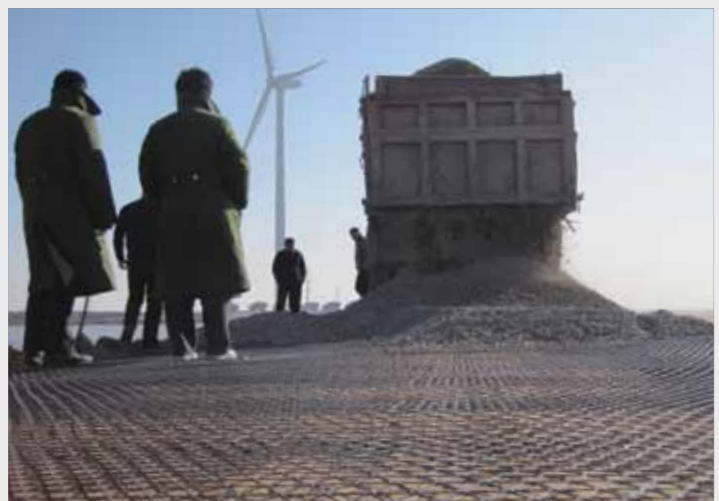
Georuszty TriAx stosowane do utworzenia warstwy stabilizowanej mechanicznie w konstrukcji nawierzchni drogi dojazdowej na farmie wiatrowej Dongying w Chinach.
