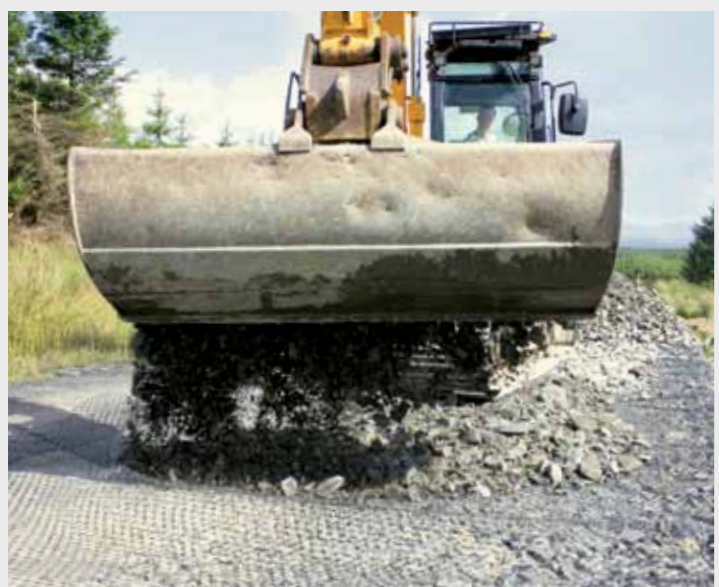
Budowa drogi dojazdowej w Arcleach w Szkocji.
