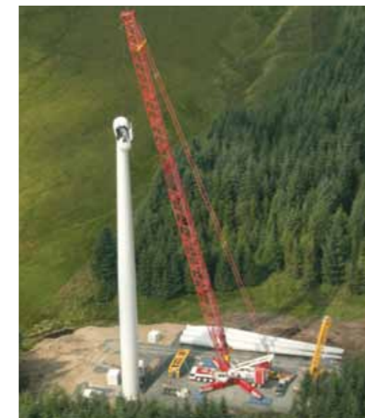
Montaż turbiny przy użyciu ciężkiego żurawia samojednego pracującego na platformie roboczej stabilizowanej georusztami Tensar – Hadyard Hill, Szkocja.
