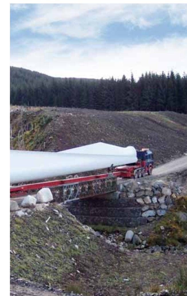
Systemy konstrukcji z gruntu zbrojonego TensarTech® pozwalają na bardzo szybkie wykonanie przyczółków mostowych i ścian oporowych (fotografia udostępniona przez szkocki zarząd lasów – Forestry Commission).
