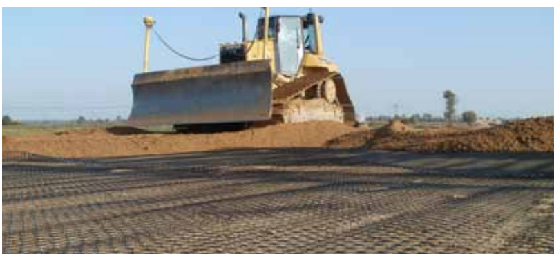
Zastosowanie georusztu Tensor TriAx, Południowa Obwodnica Gdańska
