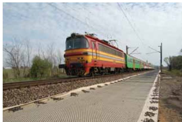
Przebudowa toru na podłożu o niskiej nośności poprzez stabilizację warstwy ochronnej georusztem (Bratysława, Słowacja).
