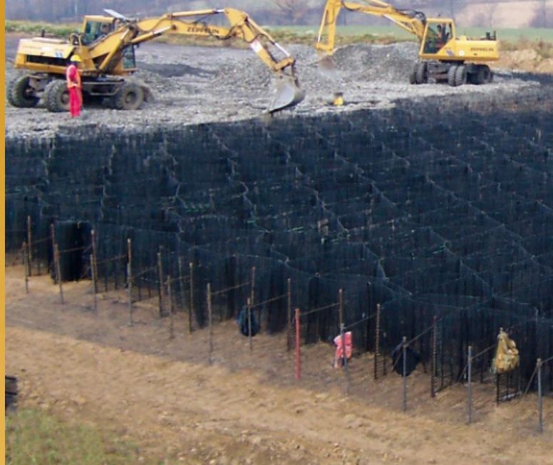
Posadowienie na materacu komórkowym w Systemie TensarTech® Stratum® zastosowano w celu eliminacji nierównomiernych osiadań na niejednorodnym podłożu (m. Czarnowąsy w ciągu DW 454).
