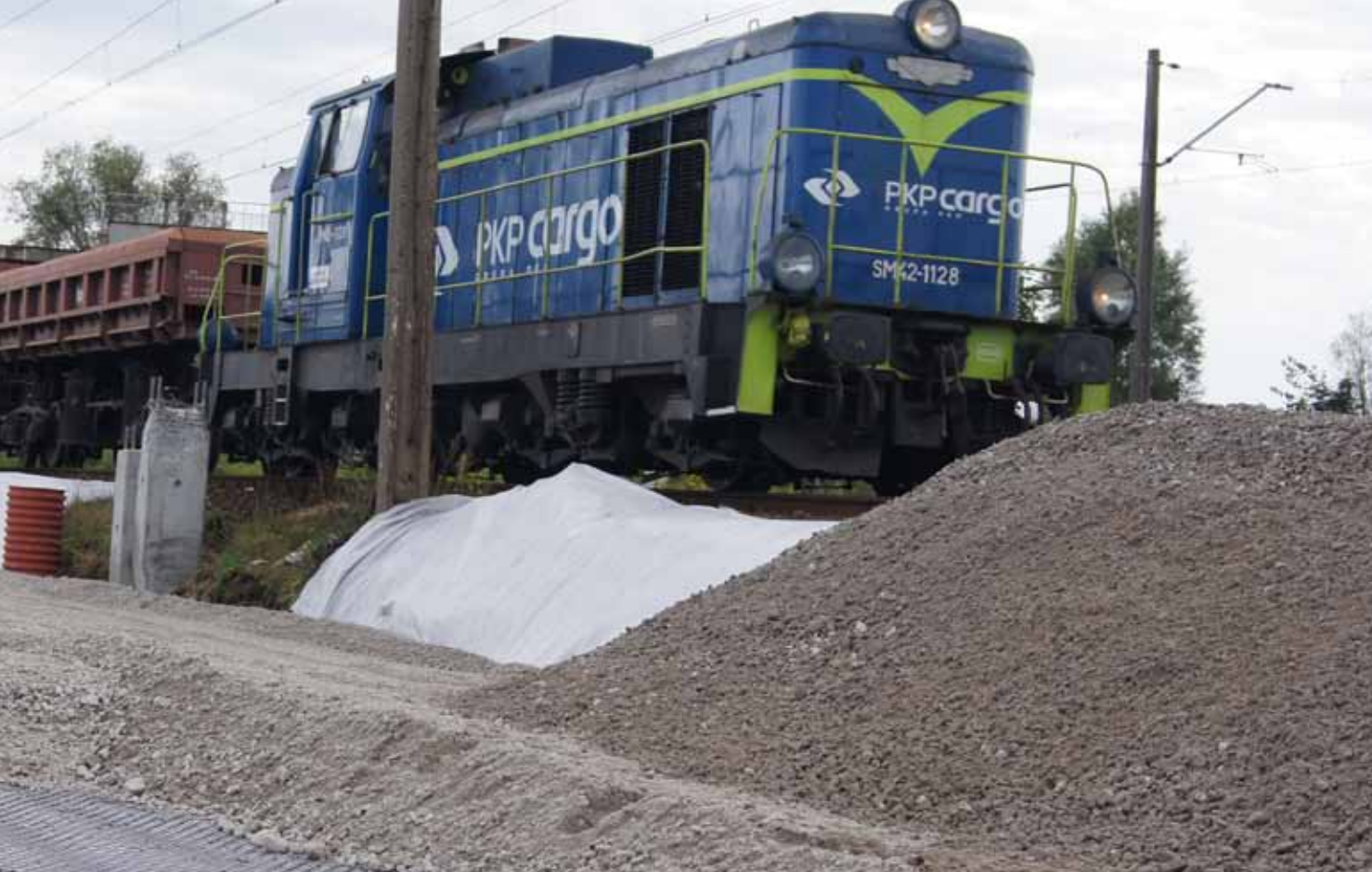
Przebudowa toru na gruntach o niskiej nośności z użyciem warstwy ochronnej stabilizowanej georusztami Tensor TriAx (Linia kolejowa E65, LCS Gdańsk, Polska).
