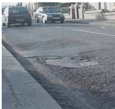
Typowe uszkodzenia nawierzchni: koleiny, spękania zmęczeniowe i spękania odbite.
