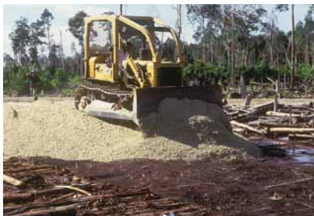
Budowa drogi z zastosowaniem platformy LTP na torfach (Indonezja).
