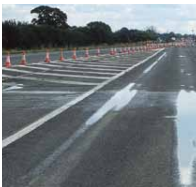
Typowe uszkodzenia nawierzchni: koleiny, spękania zmęczeniowe i spękania odbite.
