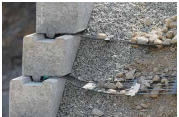
Wspólną cechą wszystkich systemów TensorTech Wall jest niezawodne połączenie między georusztem a użytym oblicowaniem - na zdjęciu widoczny jest system TensorTech Wall z oblicowaniem z bloczków TW1.
