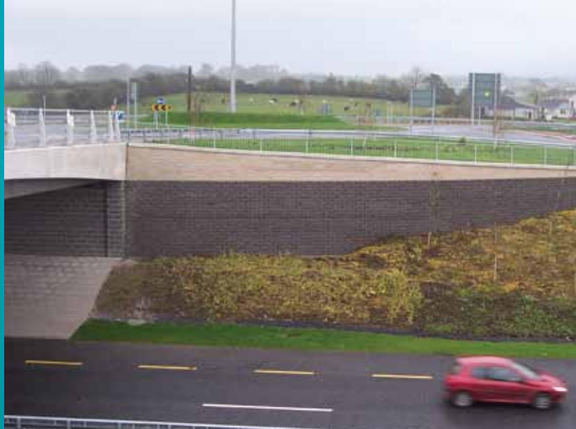
System TensarTech Wall - zastosowanie kolorowych bloczków do oblicowania skrzydełka przyczółka mostowego pozwoliło na osiągnięcie niezwykle ciekawego efektu.
