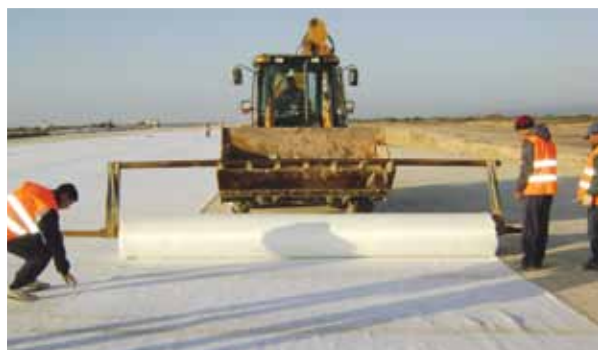
Zastosowanie geotkaniny Tensar® Basetex™ na lotnisku w Oranie zapewniło obniżenie kosztów instalacji oraz zapewniło trwałe zbrojenie o wysokiej wytrzymałości pod warstwą wypełnienia.
