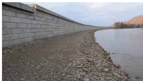
System TensarTech Marine nadaje się do zastosowania nawet w agresywnych warunkach występujących na nabrzeżach rzecznych oraz takich, jak w tej przystani.
