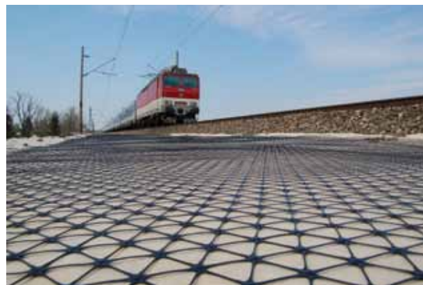
Wbudowanie georusztu w warstwę podsypki tłuczniowej (Bratysława, Słowacja).
