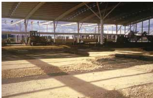
Platforma LTP dająca oparcie betonowej posadzce pod budowlą o stalowej konstrukcji ramowo-portalowej.
