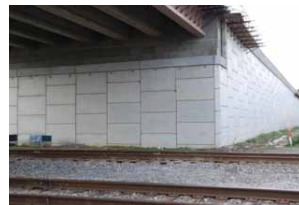
Budowa wymagających obiektów autostradowych i kolejowych o okresie eksploatacji wynoszącym 120 lat.
