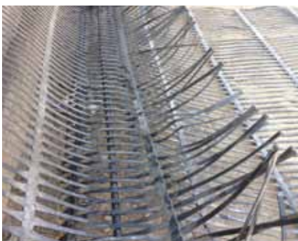
Wspólną cechą wszystkich systemów ścian oporowych TensarTech jest bardzo skuteczne połączenie między georusztem a panelami lica.
