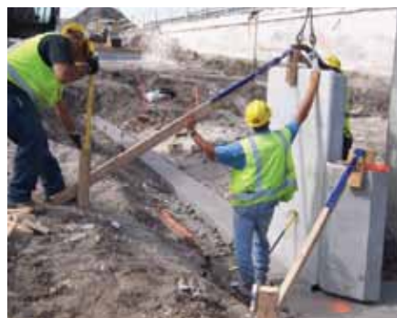
Dolne panele TensarTech Ares są układane na betonowej ławie fundamentowej, zaś kolejne panele bezpośrednio na nich, bez jakichkolwiek zapraw.
