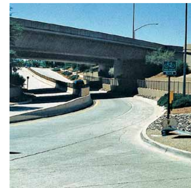
Węzeł Tanque Verde w Tucson w Arizonie – ten wzniesiony w latach 1984-85 mur oporowy był jednym z pierwszych na świecie obiektów zbrojonych georusztami Tensar. Stanowi on potwierdzenie długoterminowej skuteczności systemu ścian oporowych TensarTech Ares.
