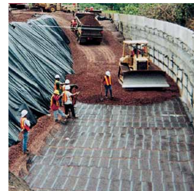
Węzeł Tanque Verde w Tucson w Arizonie – ten wzniesiony w latach 1984-85 mur oporowy był jednym z pierwszych na świecie obiektów zbrojonych georusztami Tensar. Stanowi on potwierdzenie długoterminowej skuteczności systemu ścian oporowych TensarTech Ares.
