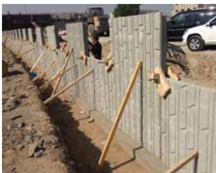
Estetyczne wykończenie lica w postaci różnorodnych faktur jest osiągnięte dzięki zastosowaniu gumowych wkładów do form podczas produkcji.
