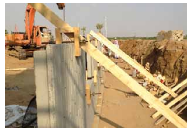
Ściany wznoszone w systemie Ares zazwyczaj wymagają tymczasowego podparcia najniższych paneli – wyłącznie w celu zapewnienia poprawnego wbudowania na poziomie fundamentu.
