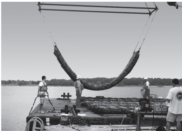
ZDJĘCIE 5: Materac morski Triton® opuszczany pod wodę w celu zabezpieczenia rurociągu.
