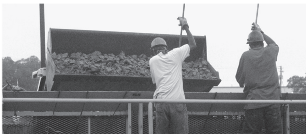
Ubijanie wypełnienia kamiennego tyczkami pozwala na odpowiednie jego zagęszczenie, dzięki czemu nie dochodzi do przesunięcia materiału podczas podnoszenia czy układania materaca.
