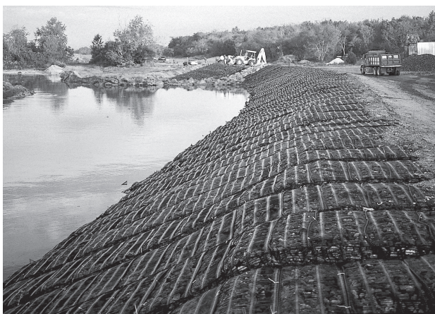
ZDJĘCIE 6: Zrealizowane umocnienie brzegu rzeki.
