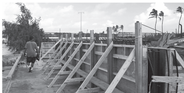
ZDJĘCIE 3: Ten drewniany stojak do wypełniania materaców został zastosowany na wyspie Kauai na Hawajach
