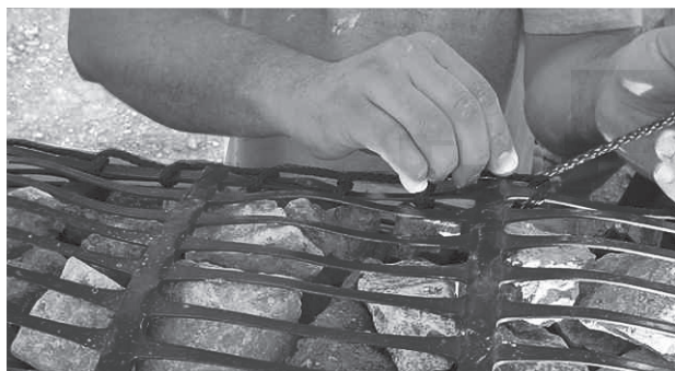
ZDJĘCIE 1: Węzły należy wiązać w taki sposób, aby zapobiec poślizgowi i nadmiernemu zaciskaniu sznura.
