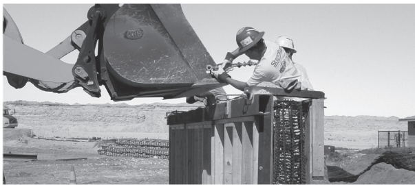
ZDJĘCIE 4: Wypełnienie z niewielkim nadmiarem - kamienie wystają nieco ponad krawędź materaca.
