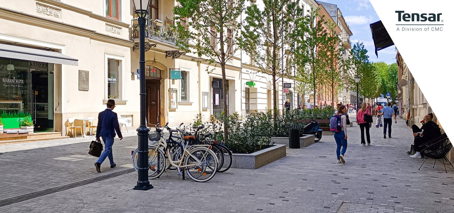
Ul. Krupnicza po zakończeniu przebudowy
