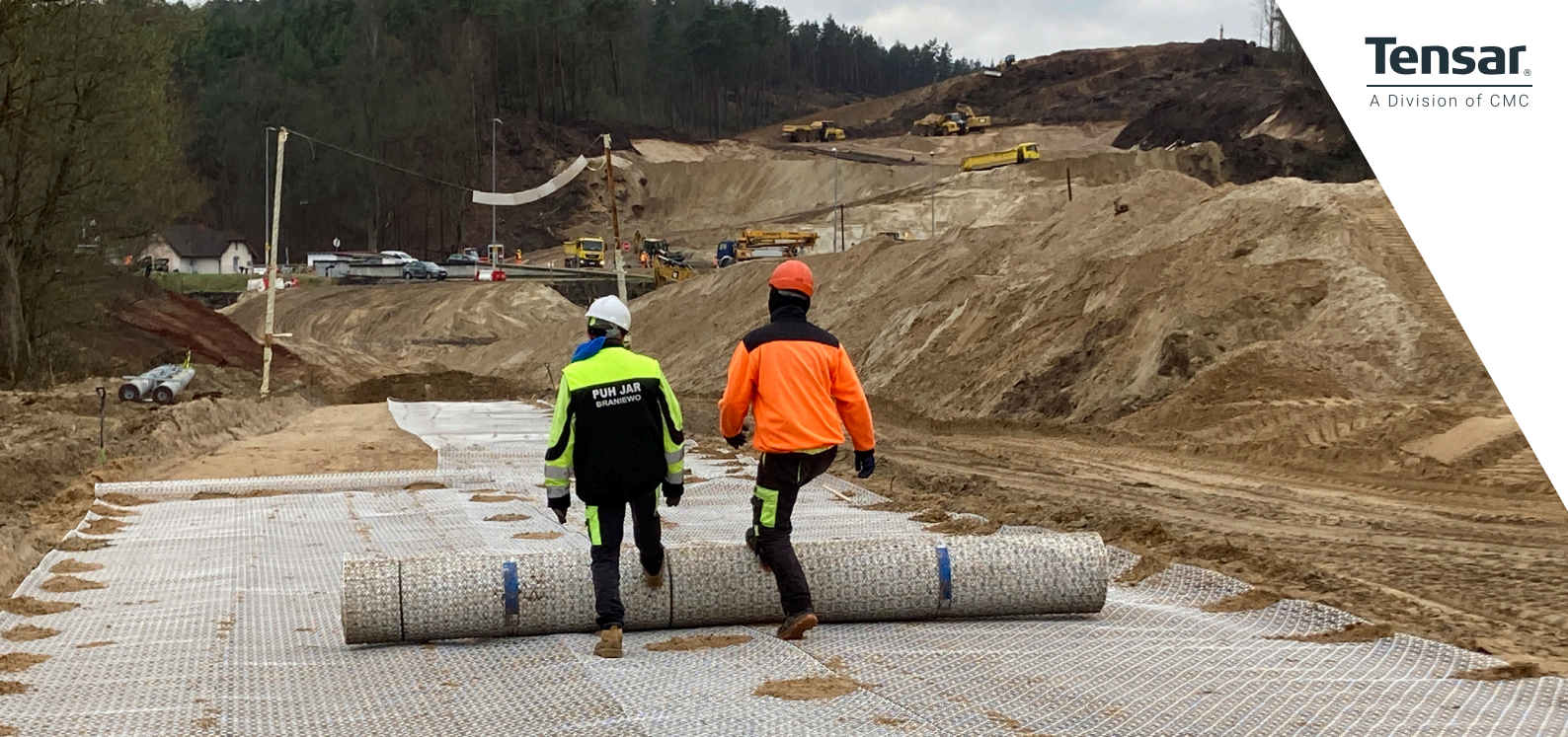
Budowa drogi ekspresowej S6 na odcinku Słupsk - Bożepole Wielkie.
