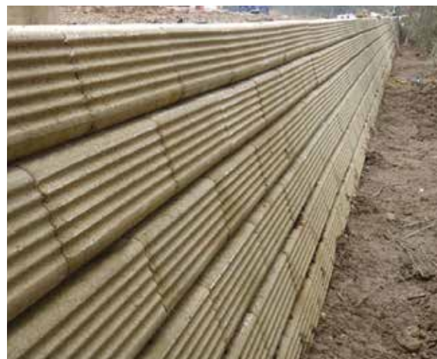
Doskonałe połączenie o wysokiej wytrzymałości pomiędzy oblicowaniem TensarTech® SlopeLoc™ a georusztem Tensar.
