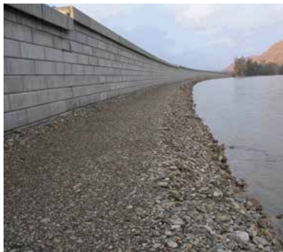
System TensarTech Marine jest doskonale przystosowany do zastosowania w agresywnych warunkach występujących na nabrzeżach – takich, jak w tej przystani.
