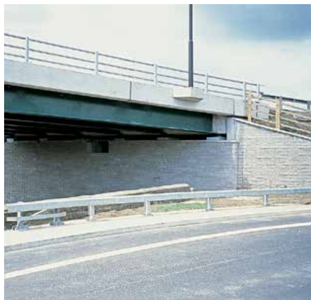
Systemy TensarTech uzyskały niezależny certyfikat British Board of Agrément, pozwalający na ich zastosowanie w przyczółkach mostowych na obiektach autostradowych.
