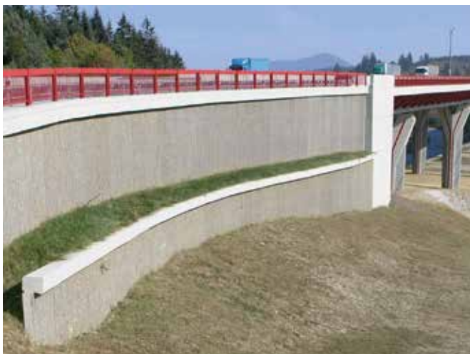
Zastosowanie paneli zarówno prefabrykowanych jak i wylewanych na budowie pozwala na osiągnięcie różnorodnej gamy wzorów i faktur lica.
