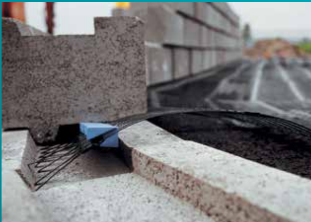
Cechą wyróżniającą wszystkie systemy TensarTech® Wall jest niezawodność elementów łączących georuszt z wybranym oblicowaniem.
