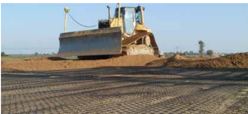
Zastosowanie georusztu Tensor TriAx, Południowa Obwodnica Gdańska
