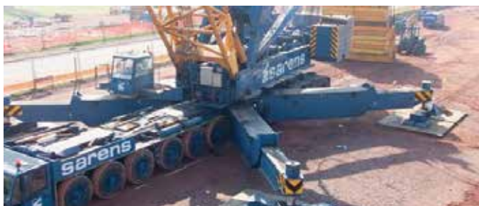
Ciężki dźwig posadowiony na platformie roboczej wykonanej z kruszywa stabilizowanego georusztem Tensar
