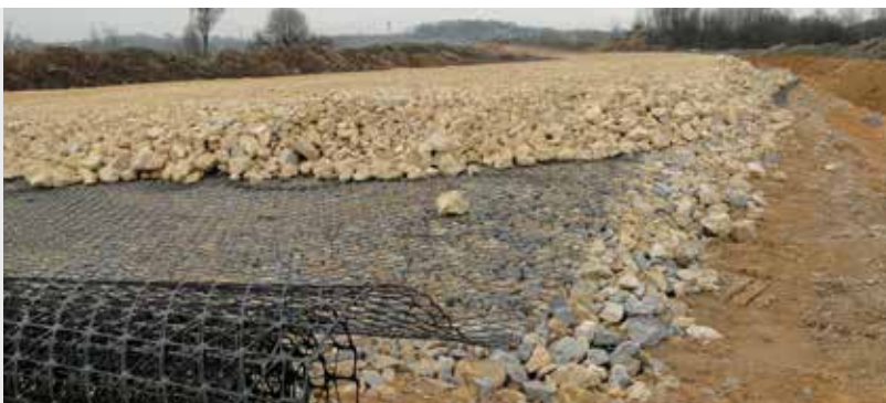
Warstwa kruszywa stabilizowanego georusztem Tensor TriAx, Obwodnica Bytomia
