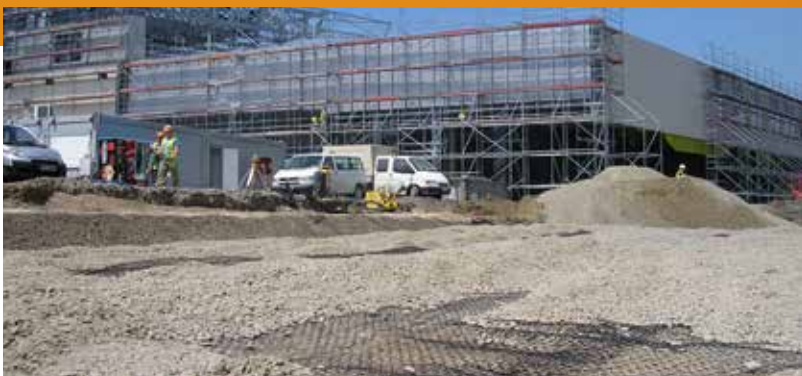
Wbudowanie georusztów Tensor TriAx, Budowa stadionu KS Cracovia, Kraków
