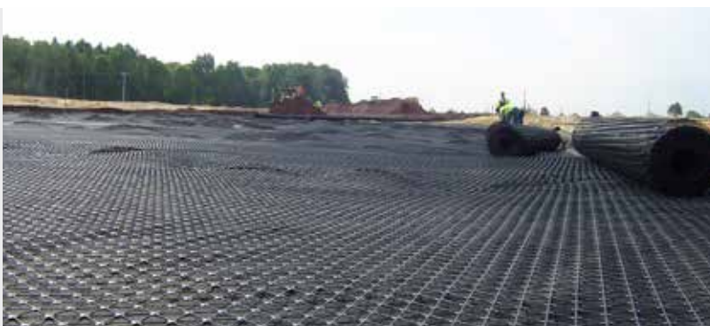
Wzmocnienie słabego podłoża georusztem Tensor TriAx, Autostrada A-1 Bełk-Świerklany
