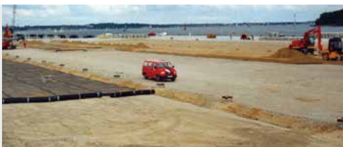
Georuszty Tensar doskonale sprawdzają się jako zbrojenie nawierzchni portowych placów przeładunkowych (Łotwa)
