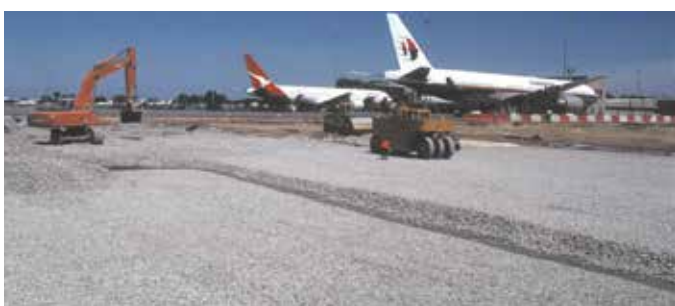
Nowa droga kołowania na lotnisku w Adelaide (Australia)
