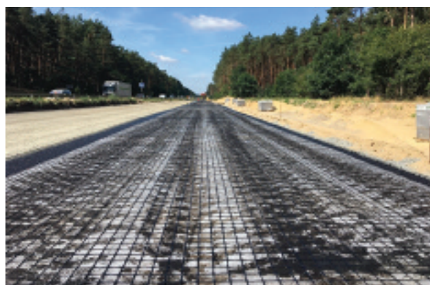
Fot. 2. Prawidłowo ułożony kompozyt Tensar AR-GN
